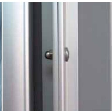
**Проверить, чтобы не было зазоров между соединенными частями.**
