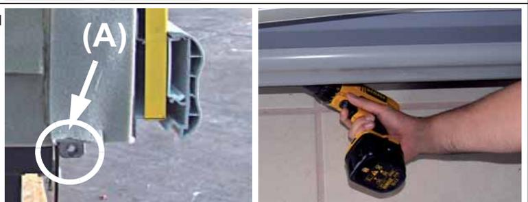
13. Зафиксировать болты соединения на крыше витрины.
