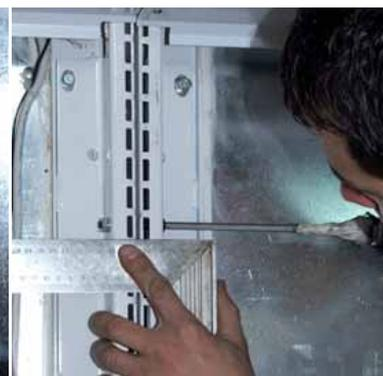
15. Зафиксировать фланцы передней части витрины винтами, в комплекте поставки.
