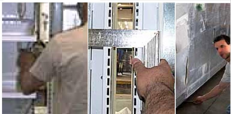
12. Соединить базу, фиксируя скобу соединения
